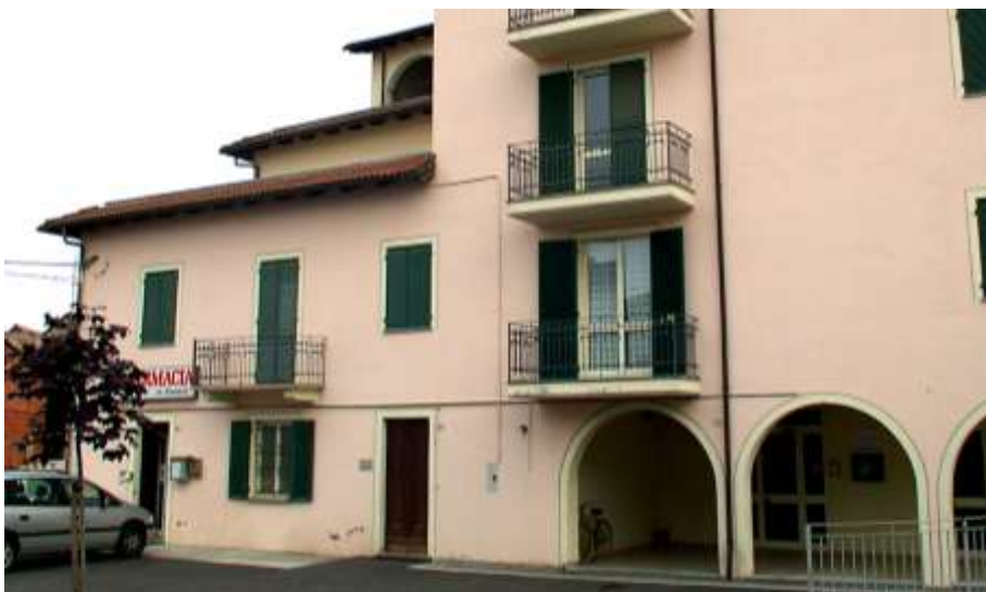
Centro di incontro di Bergamasco
